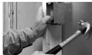
Figure N2. Installation du boîtier de raccordement électrique
