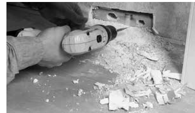
Figura R3. Preparación del agujero pasacable
