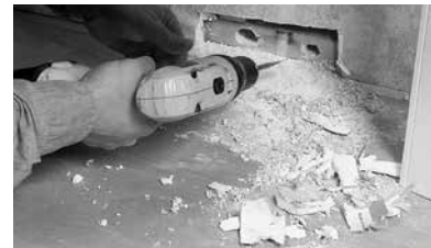
Figure R3. Préparation du trou de tirage
