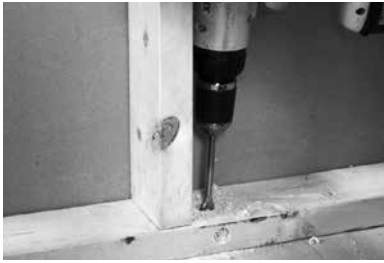
Figure N4. Préparation du trou de tirage
