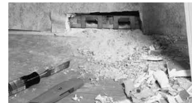
Figura R4. Limpieza del agujero pasacable
