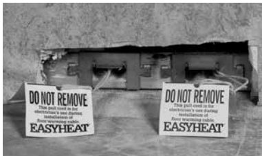
Figure R6. Installation du fil de tirage
