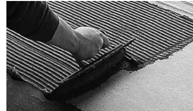
I5. Extienda una capa fina de mortero de cemento
