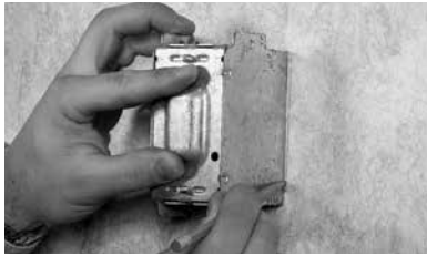
Figura R5. Marcado de los contornos en la pared
