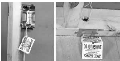
Figura N7. Instalación de las etiquetas "Do Not Remove"
