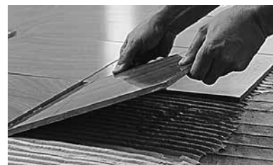
T3. Appliquer une couche mince de lit de mortier et installer la couverture de surface
