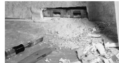
Figure R4. Nettoyage du trou de tirage
