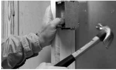
Figura N2. Instalación de la caja de conexión eléctrica
