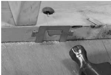
Figura N5. Instalación de los protectores
