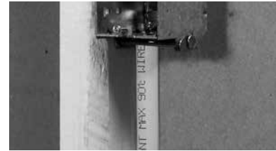
Figure N8. Conduit installation
