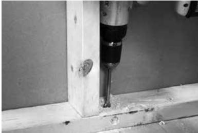
Figura N4. Preparación del agujero pasacable
