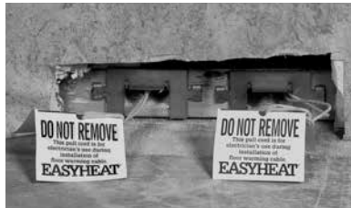
Figura R6. Inserción de la guía pasacable
