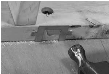
Figure N5. Installation de protège-câbles
