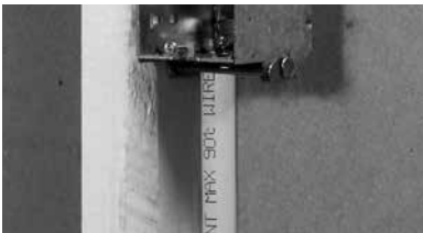
Figure N8. Installation du conduit
