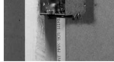
Figura N8. Instalación de conductos para cables
