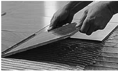
T3. Extienda una capa fina de mortero de cemento y complete la superficie
