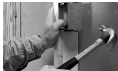
Figure 1a. Installation du boîtier de raccordement électrique
