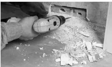
Figure 1d. Préparation du trou de tirage
