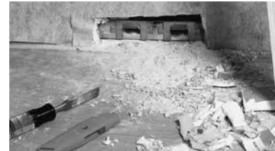
Figure 1e. Nettoyage du trou de tirage
