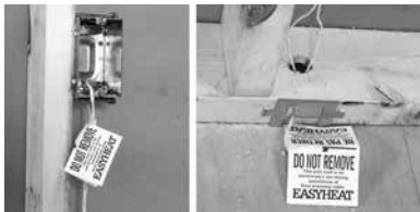
Figura 1c. Instalación de las etiquetas "Do Not Remove"
