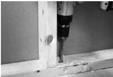
Figura 1b. Preparación del agujero pasacable
