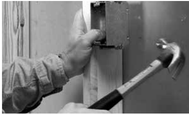
Figura 1a. Instalación de la caja de conexión eléctrica
