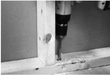
Figure 1b. Préparation du trou de tirage
