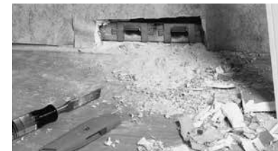
Figura 1e. Limpieza del agujero pasacable
