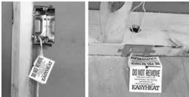
Figure 1c. Installation d'étiquettes « Ne pas enlever »
