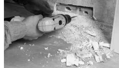
Figura 1d. Preparación del agujero pasacable
