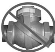
C.) Inkorrekte Installation: Heizband ist überlappt mit sich selbst
